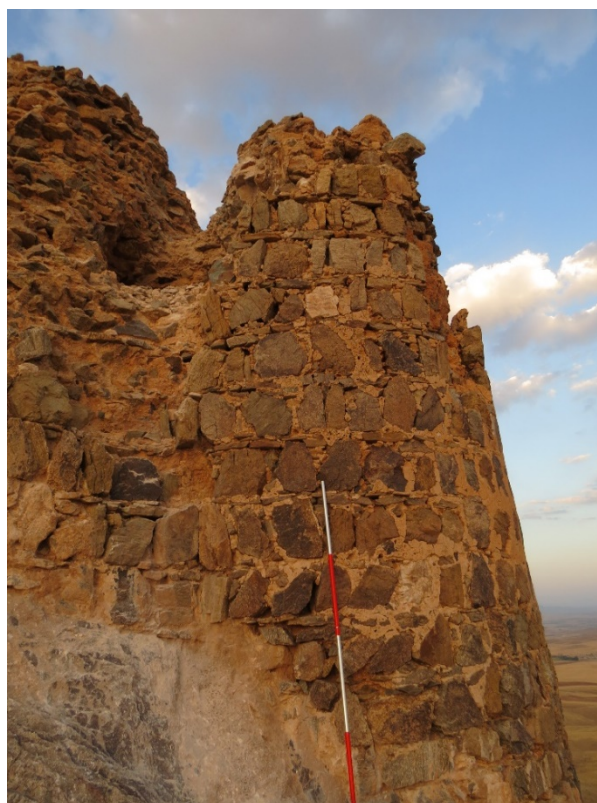
شکل ۱۲-برج مدور قلادز (دید از جنوب شرق)، سمت چپ (دید از جنوب)
