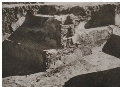
۲- تپه حصار، ساختمان سوخته، در فضای شماره ۱ برای دسترسی به بام و بالای اتاق ۶ (اشمیت، ۱۳۹۱: ۲۲۷)
