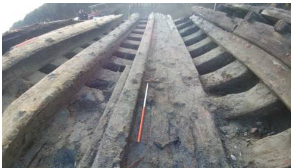
شکل ۲۴- جزئیات کشتی تاریخی قرق: اسکلت قوسی شکل، الوار عمود بر اسکلت و تخته‌های کف کشتی تاریخی قرق (بخش پاشنه کشتی) (توفیقیان، ۱۳۹۸)
