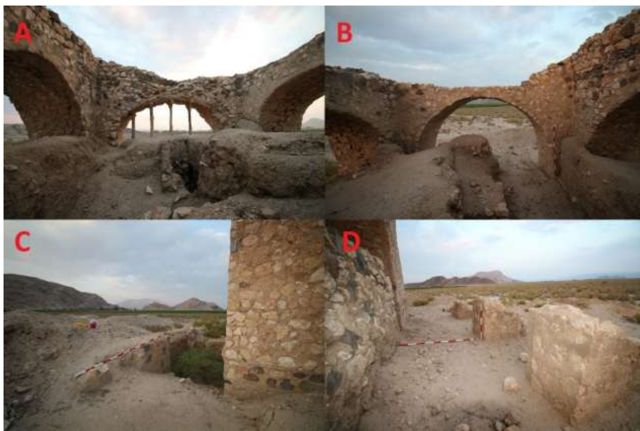
شکل ۵- (A) نمای داخلی ضلع غربی، (B) نمای داخلی ضلع شرقی، (C) بقایای برجستگی‌های ضلع شمالی، (D) بقایای برجستگی‌های ضلع جنوبی (نگارندگان)
