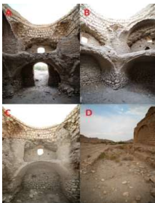
شکل ۹- (A) نمای داخلی ضلع شمال شرقی، (B) نمای داخلی جرز جنوبی، (C) نمای داخلی ضلع جنوب غربی، (D) فضاهای معماری ضلع شمال غربی چهارطاقی رحمت‌آباد (نگارندگان)
