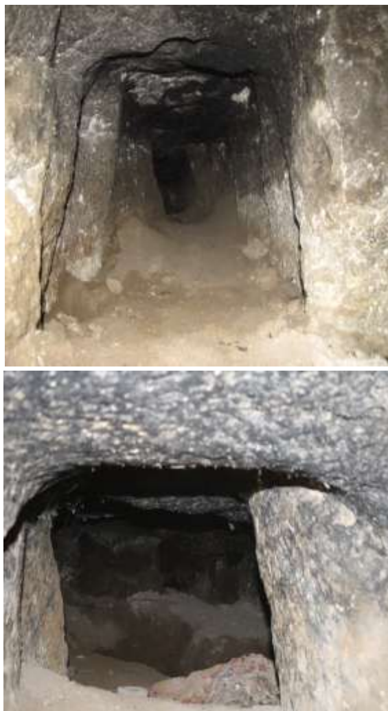
شکل ۱۷- فضای داخلی تونل، قسمت فضای اتاق مانند مجموعه و ورودی دالان‌ها
