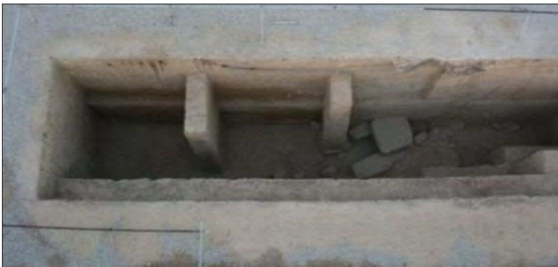
شکل ۱۲- آبراه شماره ۴؛ نمای کلی
